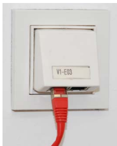
Abbildung 2 Kategorie 6 Datenanschlussdose mit zwei RJ-45 Buchsen
